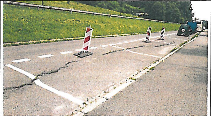
Widok na skarpe osuwiska od zachodu
