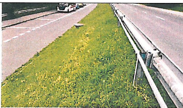
Widok na zbocze ponad jezdnią niszczone przez osuwisko
