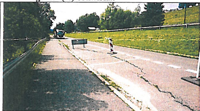
Widok na skarpe osuwiska od wschodu
